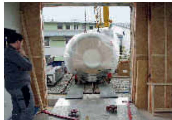
Abgesetzt wurde das Gerät auf einem Podest vor dem Gebäude. Dann musste es mittels Hydraulik und Muskelkraft ins Innere gebracht werden. Fotos: red
