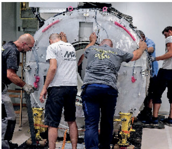
Starke Arme und viel Know-how benötigten die Techniker beim Einbringen des MRT.
