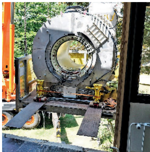
Der MRT wurde durch die geöffnete Fassade ins Haus gebracht.
