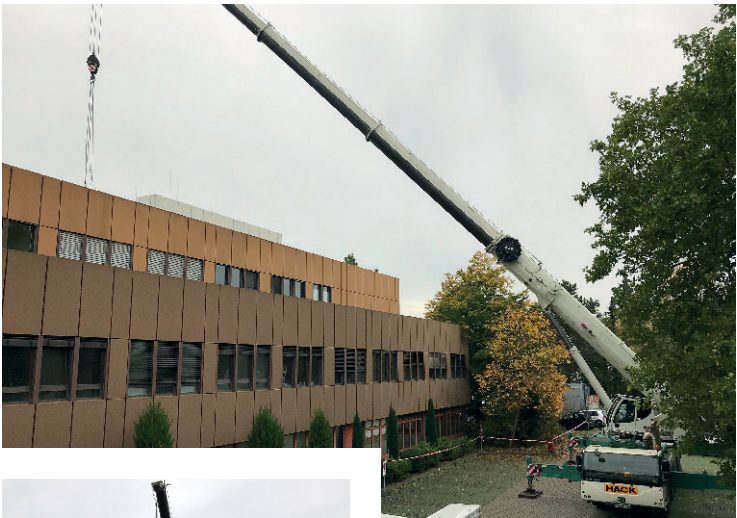
Ein großer 100-Tonnen-Kran hob die neue Lüftungsanlage auf das Dach des Klinischen Zentrums.
