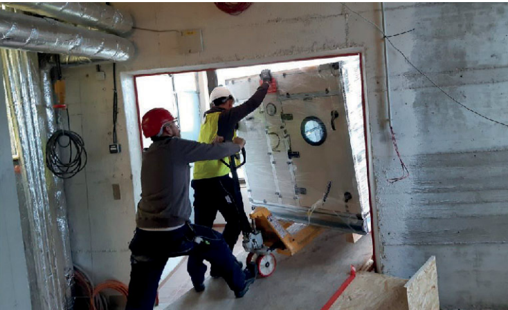
Knackpunkt bei der Anlieferung war die nur geringfügig größere Einbringöffnung in der Lüftungszentrale.
