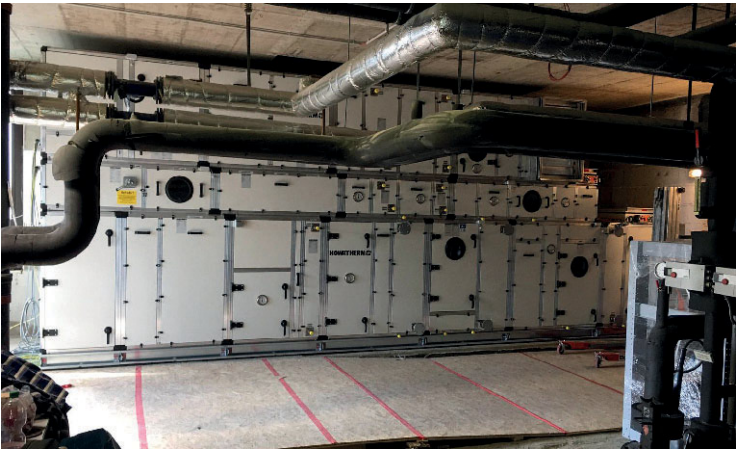
Die Puzzleteile der Lüftungsanlage mussten im Haus wieder zusammengesetzt werden.
