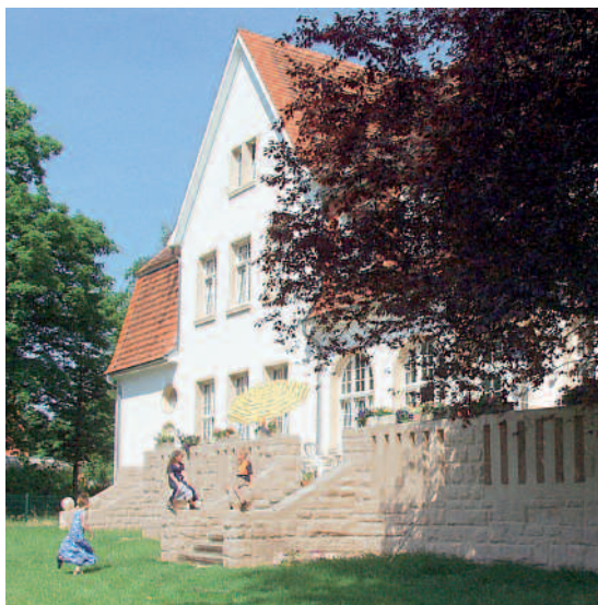
Terrasse und Grünanlage vor Haus Petersberg
